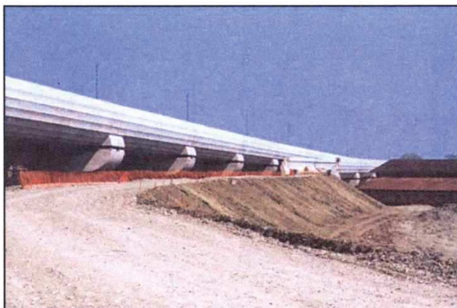
Figura 6 – Parte del rilevato ferroviario realizzato con la miscela ricuperata.
