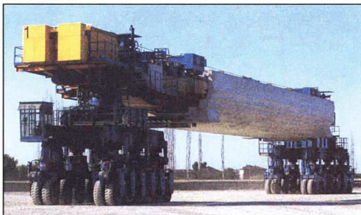
Figura 3 - Trasporto con il carro speciale di una trave a omega del viadotto Modena.
